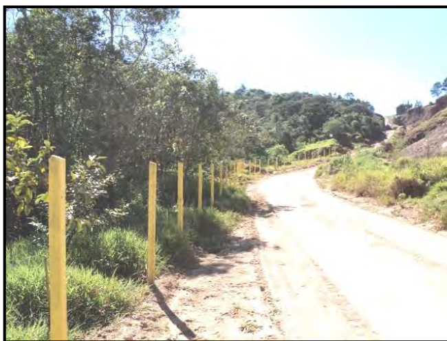
FOTO 5.4.2.1 – Exemplo de delimitação de área de recuperação ambiental com marcos de concreto.
