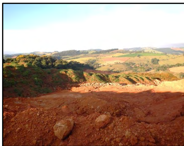
FOTO 3.1.12 – Leiras de armazenamento do solo orgânico, ao fundo, para posterior utilização na recuperação da área de lavra.
